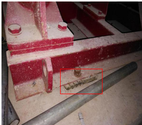
项目水泵减震垫
