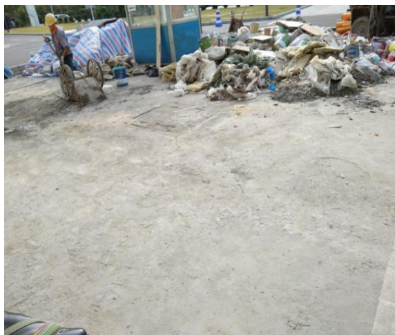
项目地埋式污水处理站位置（位于 D 栋西侧）
