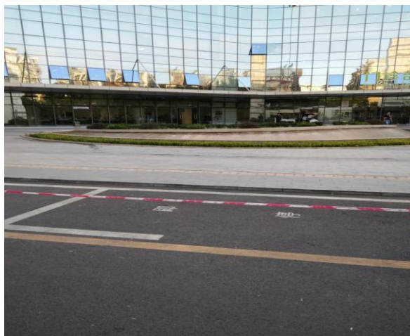
项目建筑外围道路硬化
