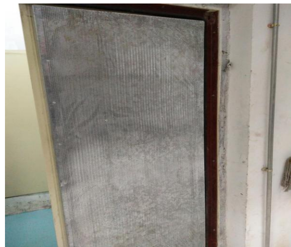
发电机房隔声门
