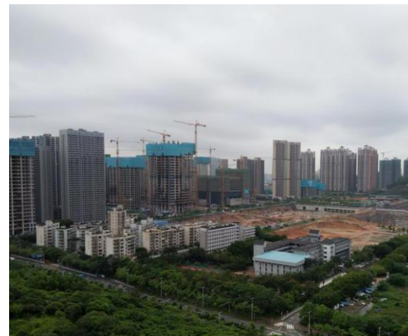
项目西面 建筑工地
